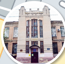
XVII корпус ул. Заулошнова, 5
