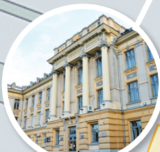
I корпус ул. Московская, 155
